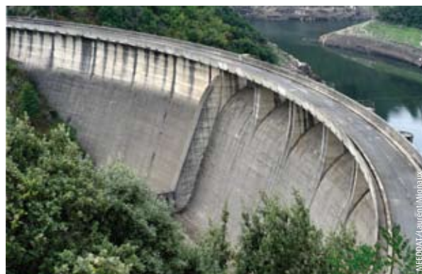
Barrage écrièteur de crues et soutien d'étiage de Sénéchas, situé sur la rivière « la Cèze », affluent du Rhône (30)
