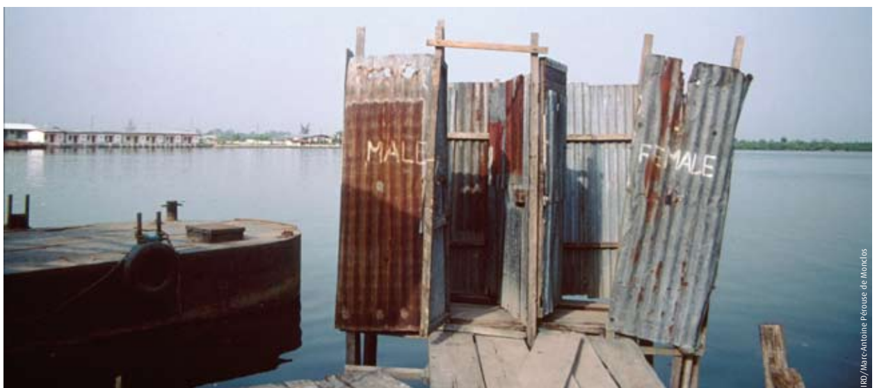
Bidonvilles lagunaires : des sanitaires précaires - Port Harcourt (Nigeria)
